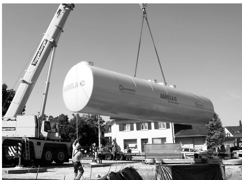
Der 110 000 Liter fassende Tank wird platziert.
